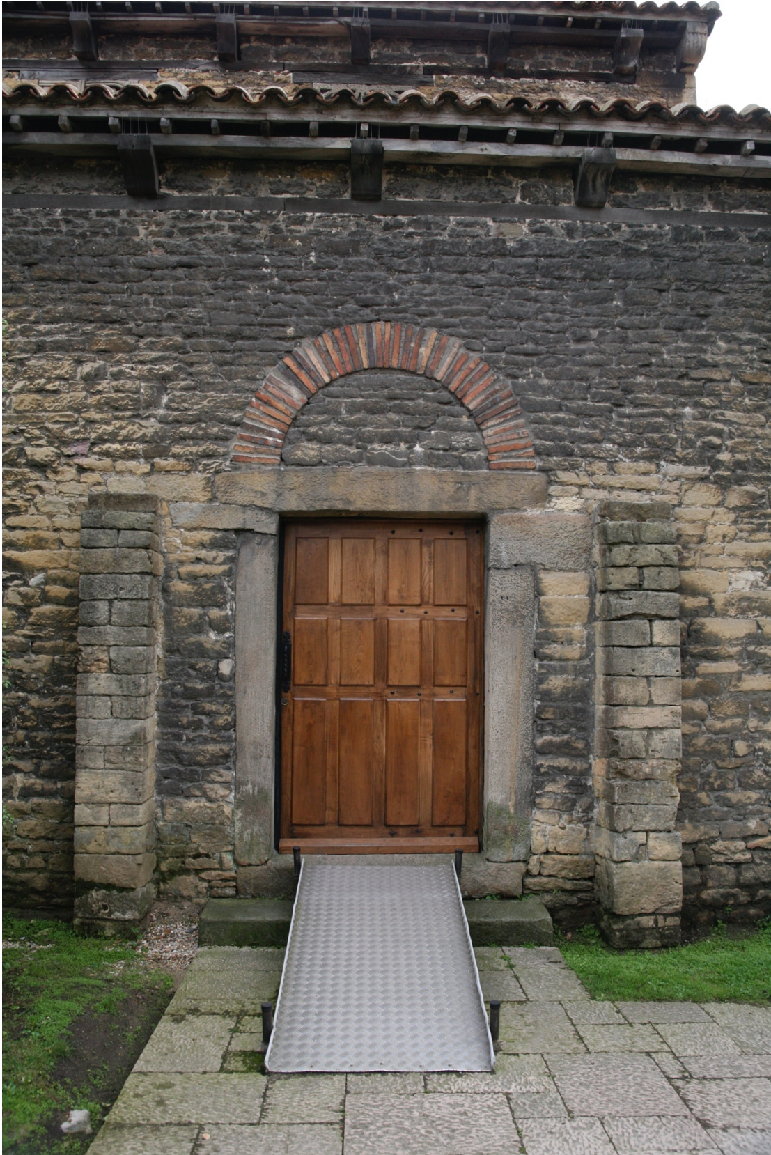
Figure 30.12: San Julián de los Prados, Asturias, north west aisle portal.
